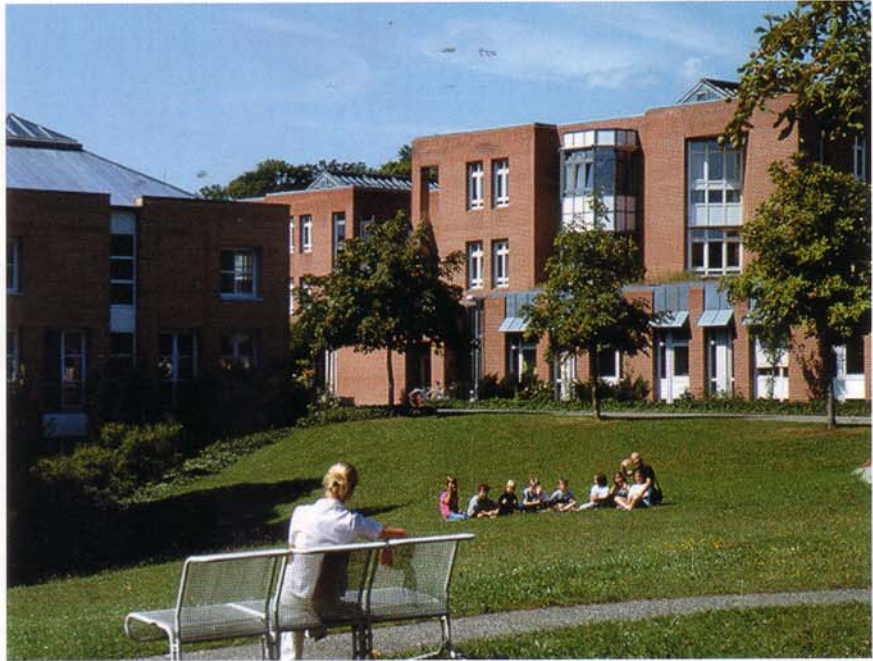
Das PZ-Nordbaden verfügt über 480 PCs in insgesamt 55 Gebäuden.
